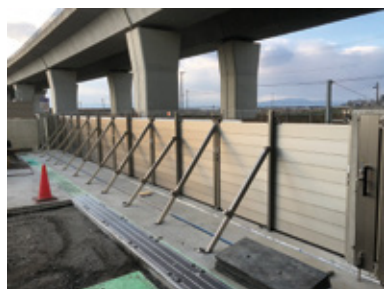
設置例① 工場メイン出入口 (幅 17.6 m)
